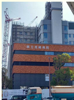
建築が進む県立宮崎病院 ↓
