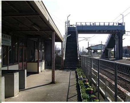
跨線橋を撤去して、駅舎から直接ホームに渡ることが出来る通路を設けるそうです。
